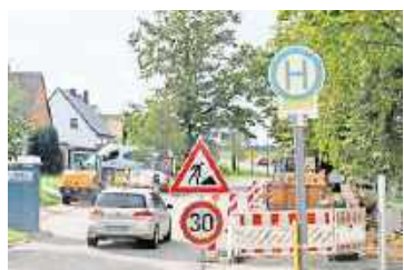
Die Mitarbeiter von Bau- und Haustechnik Bad Dübener bauen seit Anfang Oktober die Bushaltestelle in Gotha um. FOTO: W. SENS
