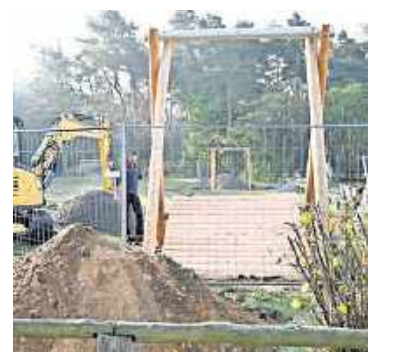
Am Spielplatz Hammermühle entsteht derzeit eine neue Seilbahn. Am 23. Oktober soll sie eingeweiht werden. FOTO: STEFFEN BROST
